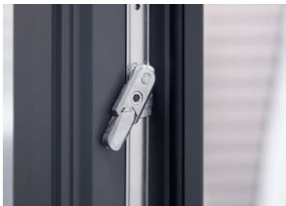
Zasuwnica z blokadą obrotu klamki i podnośnikiem skrzydła
